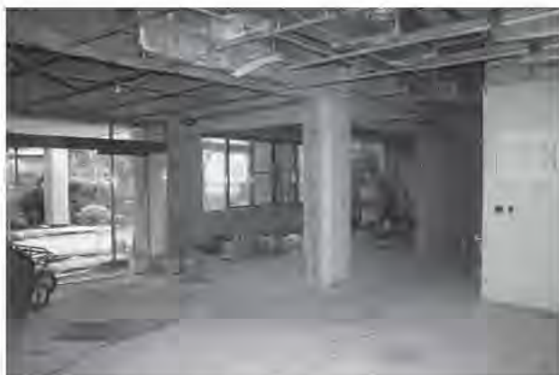
写真1 耐震補強工事
