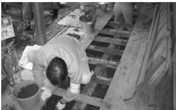
(写真10) 床板を外し、床下の土砂を除去する (新井旅館10月17日)
