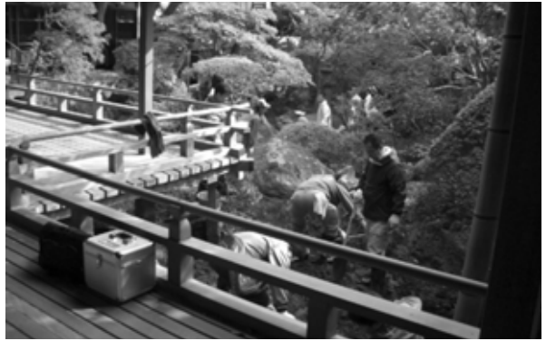
(写真11) バケツリレーによる土砂の除去 (新井旅館10月17日)
