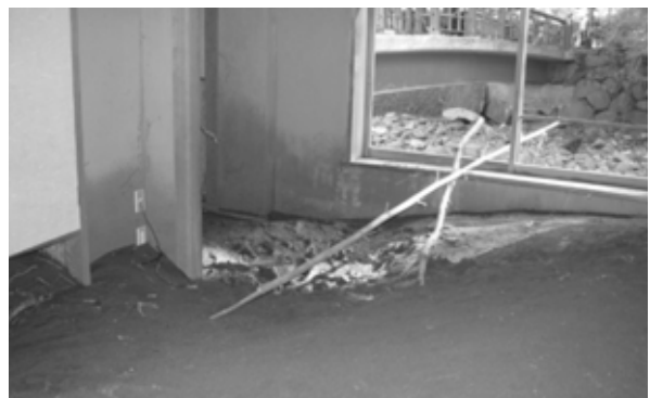
(写真8) 旅館内には土砂が残る（新井旅館10月17日）
