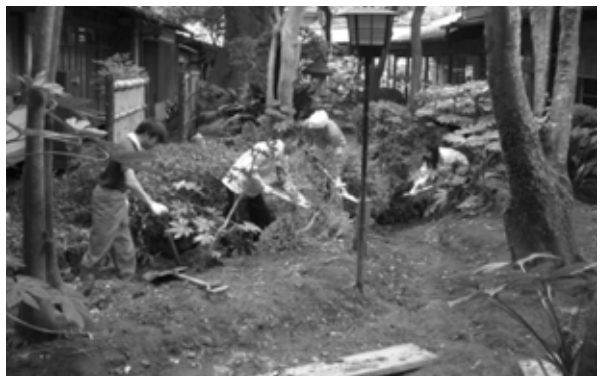
(写真12) 庭の土砂の除去作業 (新井旅館10月17日)
