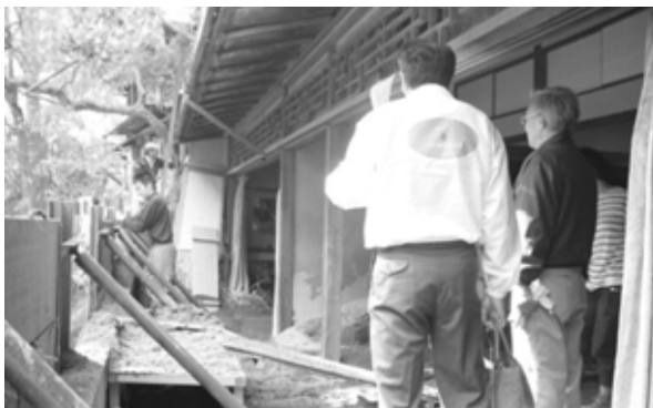
(写真9) 左手の桂川から館内へと水が浸入した (新井旅館10月17日)
