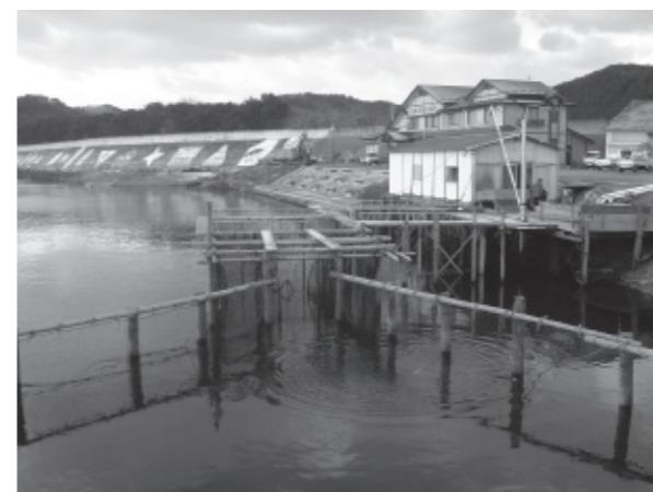
図16. 田老防潮堤。高さ10メートル、総延長は2.4キロ。右手の網は田老川のサケ漁の網。（平成18年12月撮影）
